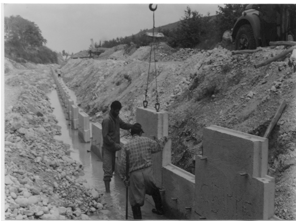
شکل ۱۲-۴- اجرای دیوار خاک مسلح
