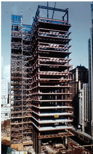
photo: H. J. Brunnier
